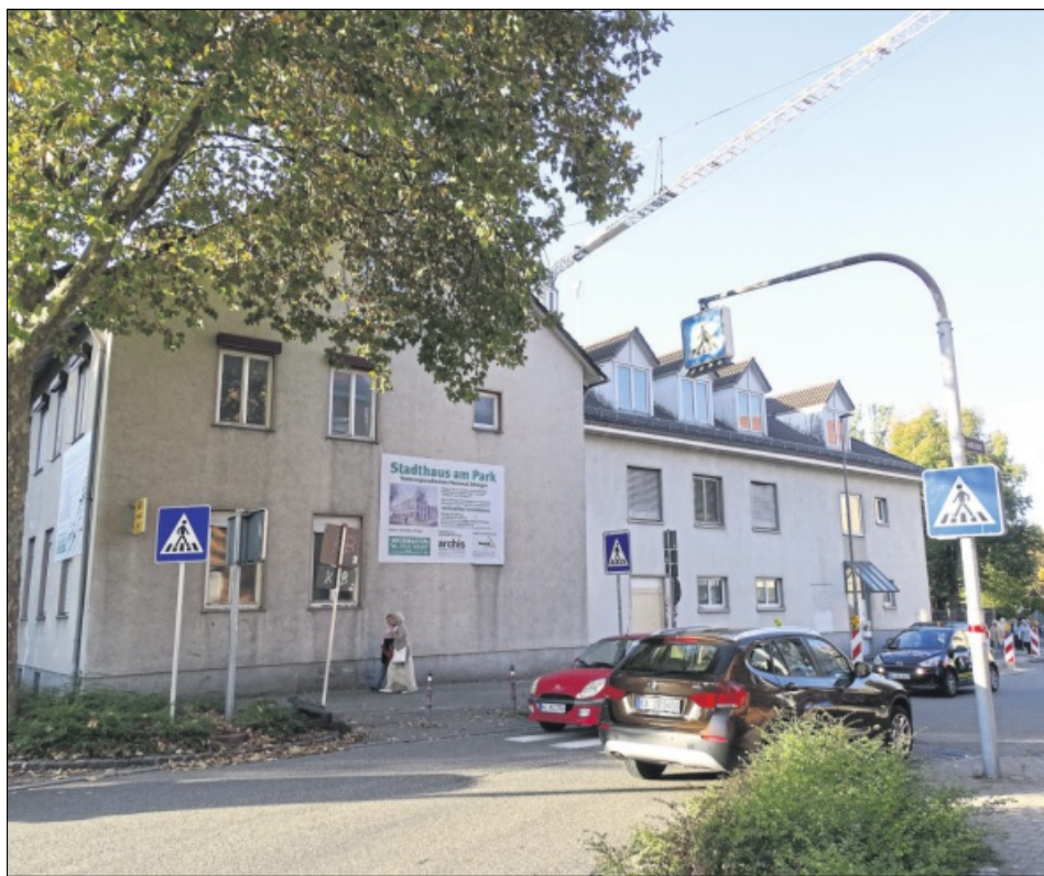
ES KANN LOSGEHEN – der Kran im Hof des Postgebäudes im Ettlinger Zentrum steht. Das Gebäude über Eck erhält ein neues Gesicht bis Mitte 2019. Foto: Heidi Schulte-Walter
